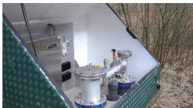
På den nye kildeplads er der 3 borer, som alle er forsynet med overjordisk råvandsstation. Boringernes dybde er mellem 80 og 100 m., og hver boring giver godt 60 m 3 /time
