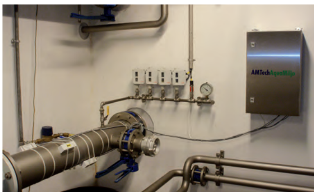
På den nye kildeplads er der 3 borer, som alle er forsynet med overjordisk råvandsstation. Boringernes dybde er mellem 80 og 100 m., og hver boring giver godt 60 m 3 /time
